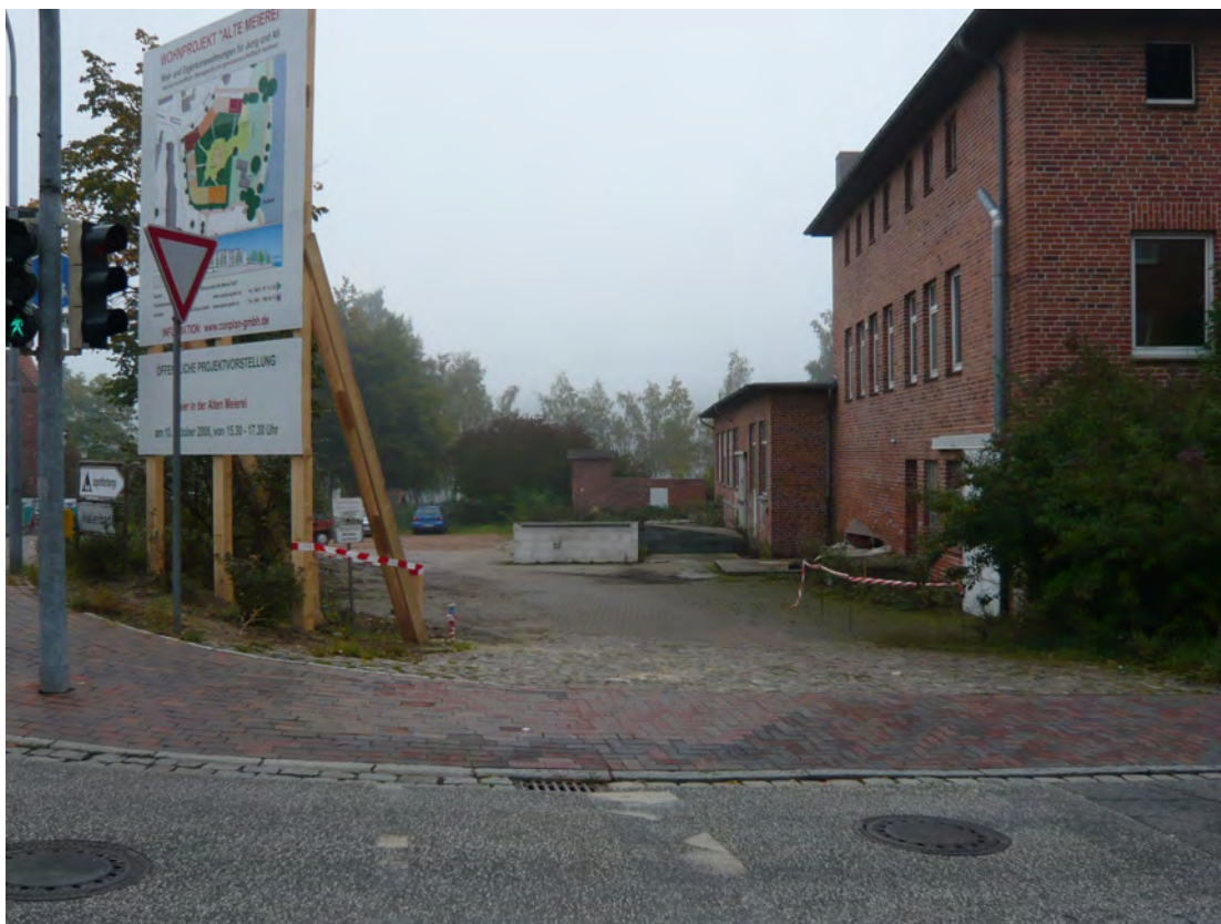
Abbildung 9: Blick von Westen (Ecke Seestraße/Fischstraße) in Richtung See
