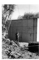
Im Bereich der "Surferwiese" wurde ein großes Regenwasserklärbecken eingebaut, das das Regenwasser aus Teilen des St. Georgsberges vor dem Eintritt in den Ratzeburger See von Schadstoffen befreit und als Sperre im Falle von Schadstoff-
