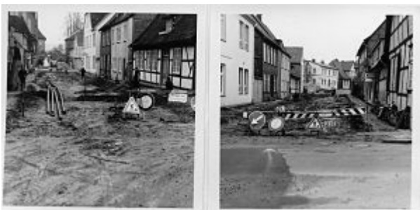
Wasserstraße während des Ausbaus
